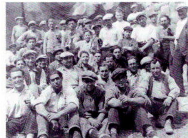
Treballadors de la pedrera propietat del Sr. Josep Ortiz. Any 1934.
