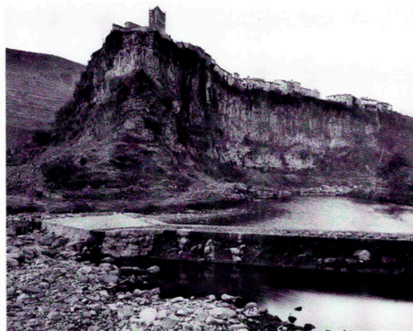
Vista panoràmica de Castellfollit de la Roca l'any 1916. L'exploració del basalt, les esllavissades, la climatologia, les noves construccions, etc. han estat els factors més destacats d'aquest penya-segat.
